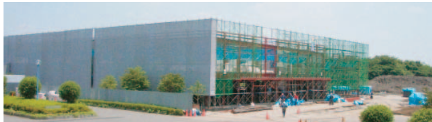
平成17年8月完成予定の新棟及びエンジン実験棟
